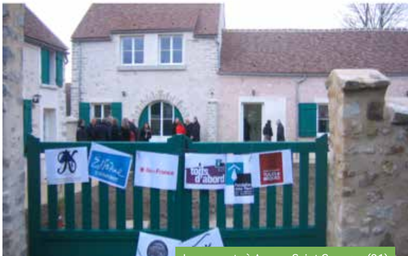
Logements à Auvers Saint Georges (91)
