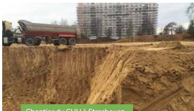
Chantier du CHU à Strasbourg
